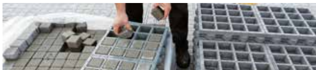
Isättning av gatstenar i TTE®-elementet
