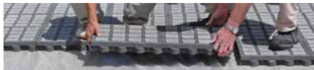
Läggning av de fyllda TTE®-elementen i par
