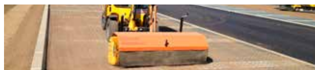
Underfyllningen görs med hjälp av en sopmaskin
