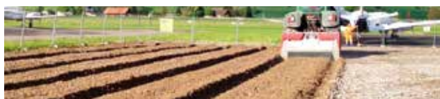
Vegetationsbärlag genom markförbättring Infräsning av grus i den befintliga markytan.
