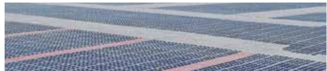
Läggning av TTE ® -gatstenar för t.ex. gångbanor och som markering
